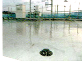
■ 屋上屋根のコーティング 紫外線をカットし、雨水の浸入を防ぎます。
